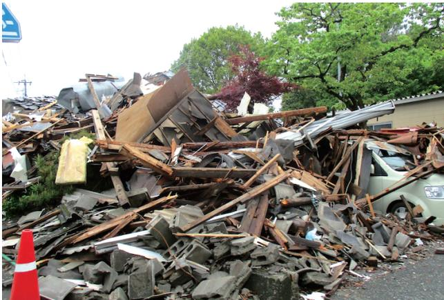
●写真2 益城町の道路沿いの倒壊家屋。その損壊の程度から二度の震度7を含む強震の繰り返しによる破壊力の凄まじさをまざまざと示していた。
